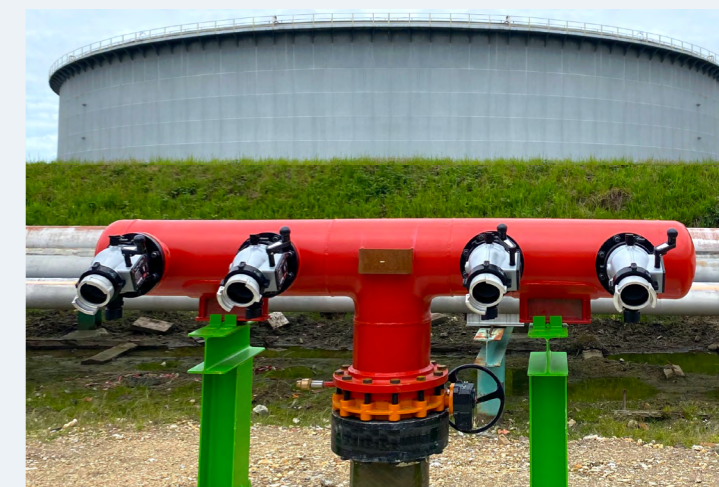
Installation sur hydrant
